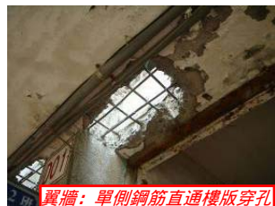
翼牆：單側鋼筋直通樓版穿孔
