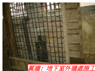
翼牆：地下室外牆處施工
