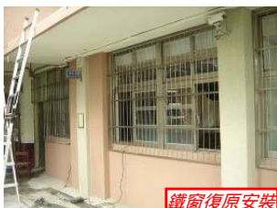
鐵窗復原安裝
