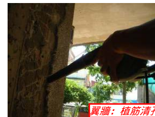
翼牆：植筋鑽孔
