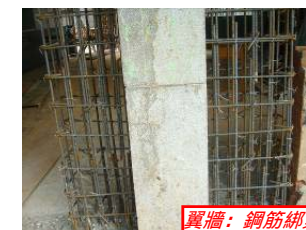
翼牆：鋼筋綁紮
