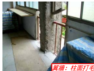
翼牆：柱面打毛
