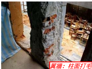
翼牆：柱面打毛
